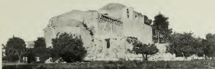
Chiesa di S. Saturnino in Cagliari (abside e fianco).
